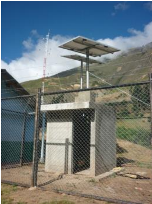
Fotos: Sistemas fotovoltaicos para iluminación, refrigeración y radio comunicación en puestos de salud e instituciones educativas
