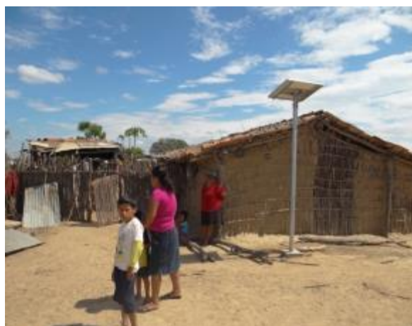
Fotos: Sistemas fotovoltaicos en viviendas y centros educativos
